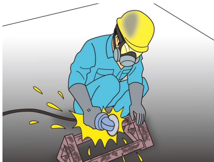
図 2 手持ち電動グラインダによる L 型軽量鉄骨の切断作業
