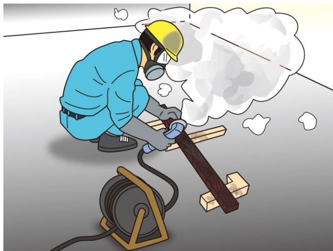
図 3 手持ち電動グラインダによる廃棄木材の切断作業
