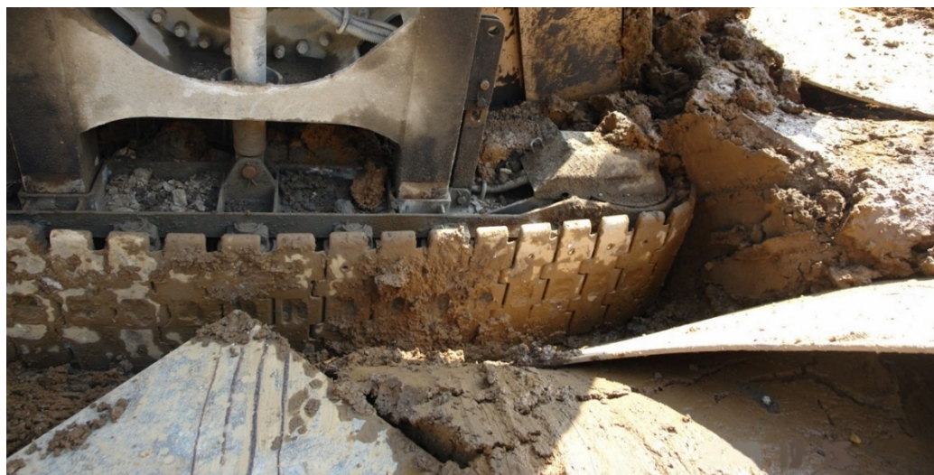
写真-1.2 沈下部周辺に見られた軟弱な地盤
