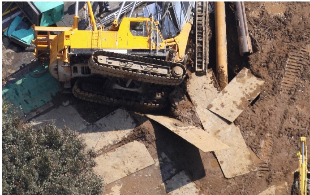
写真-1.1 転倒位置付近の状況
