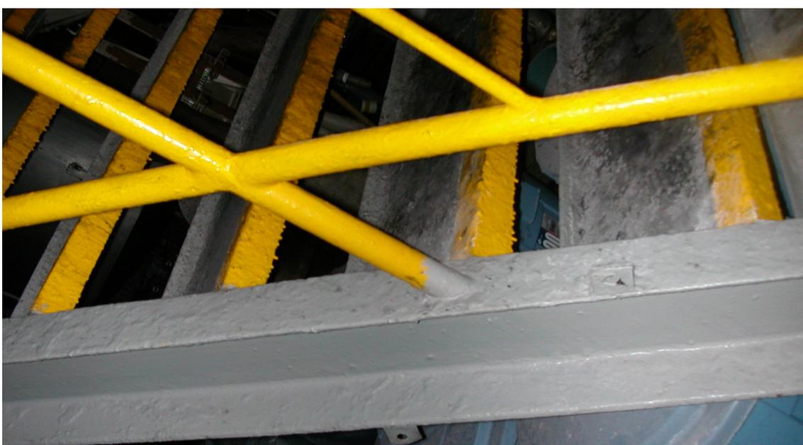
写真 3 床、階段に塗布されていた絶縁性塗料
