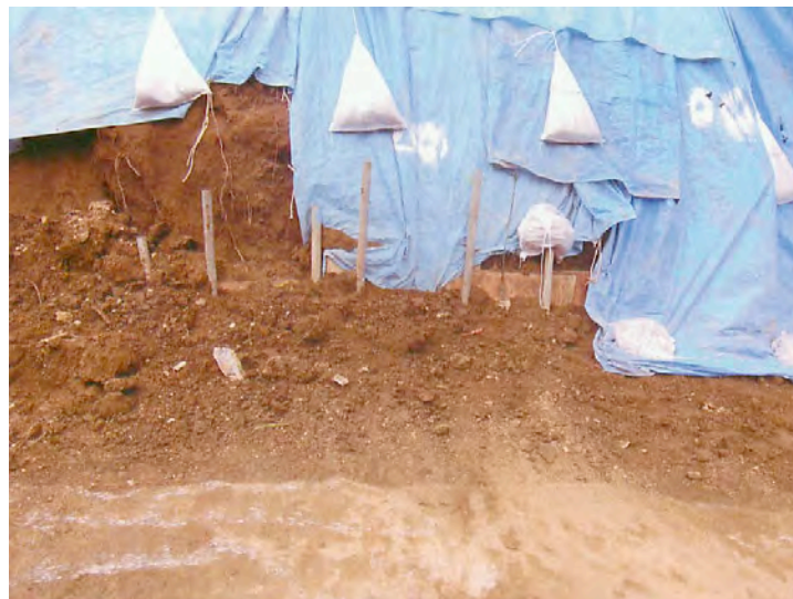
写真-1.1 仮復旧された崩壊箇所(溝は埋め戻され法面はシートで養生されている)
