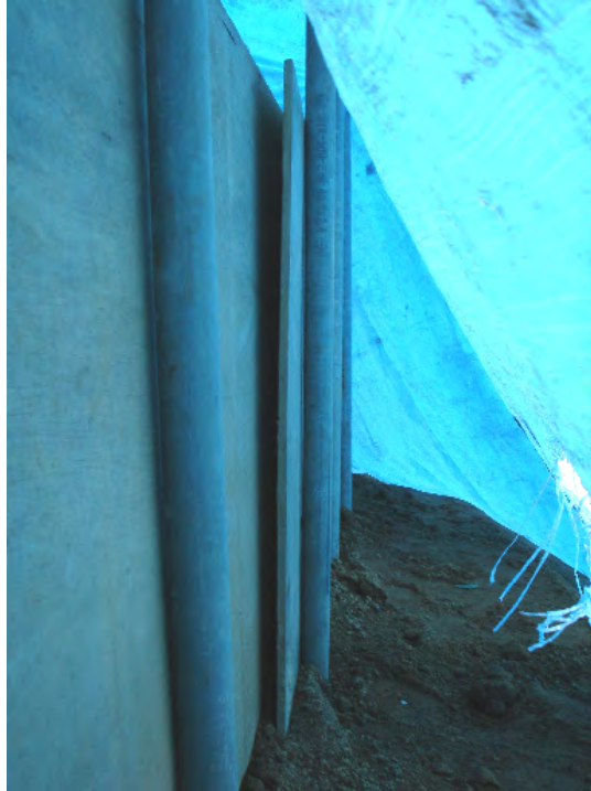
写真-2.1 単管パイプとコンパネによる簡易土止め（崩壊を免れた箇所を撮影）
