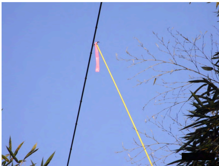
写真4 送電線と絶縁棒との離隔の状況
