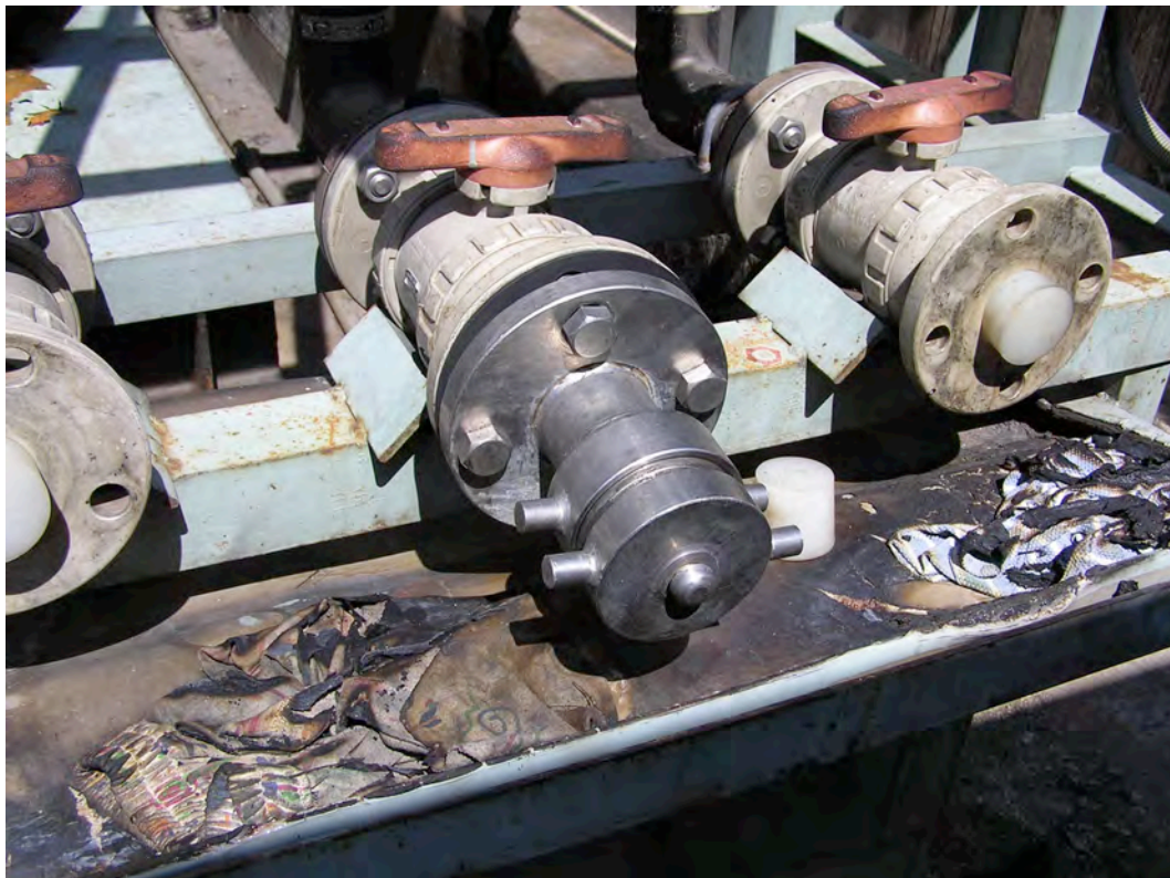
図 11: 液入口バルブとジョイント
