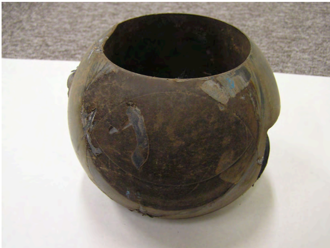
図 10: 脱臭ボールバルブのボール部の焼痕
