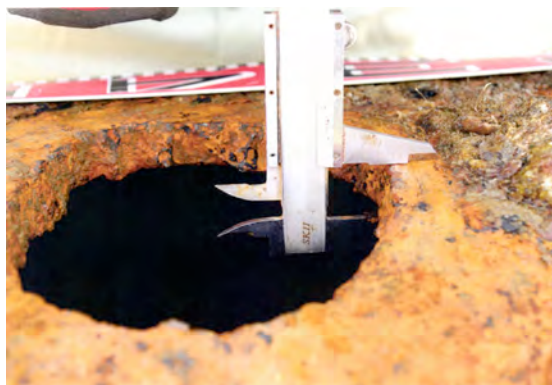
写真 6-6 貫通穴を斜めから見たところ
