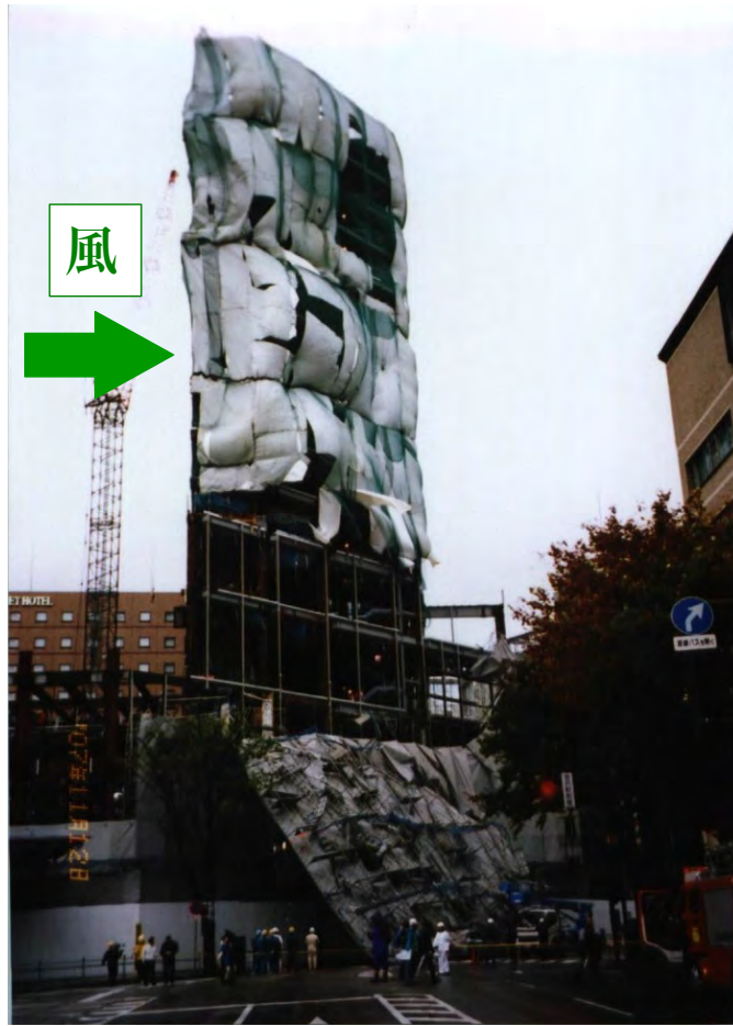
写真1 倒壊した足場
