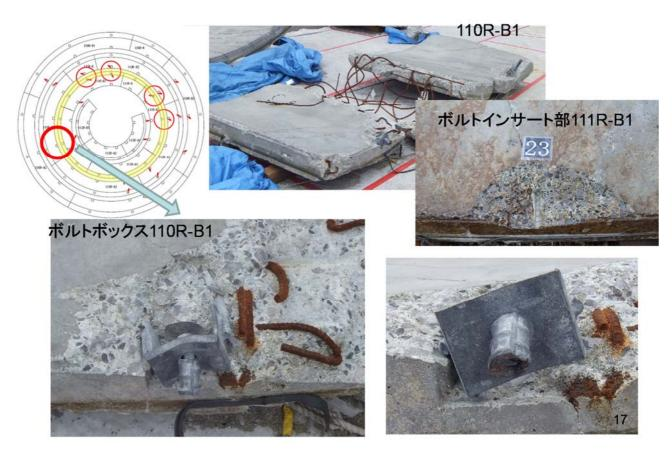
図 8.1.31 111R の B1 のボルトインサート部と 110R の A2 のボルトボックスの状況
