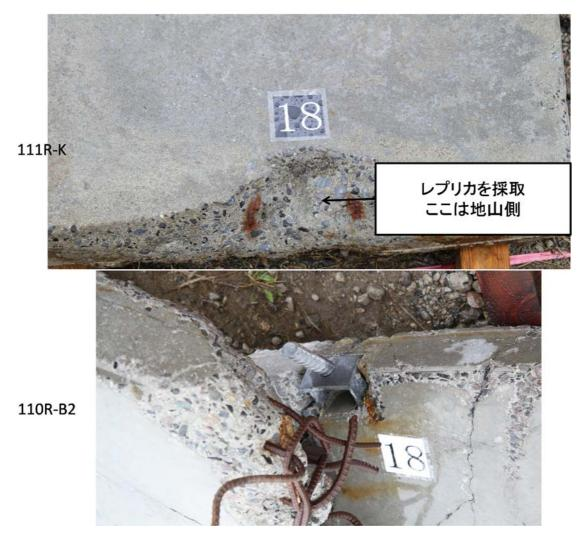
図 8.1.23 レプリカの採取箇所(111R の K セグメントのボルトインサート部) (110R の B2 のボルトボックスに、111R の K セグメントのボルトインサートが引抜けた形で残存していた)
