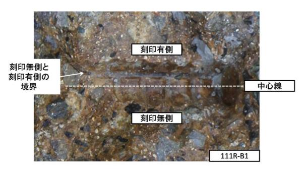
図 8.1.29 111R の B1 セグメントのボルトインサート部の拡大写真 (刻印有側と刻印無側の境界が見える)
