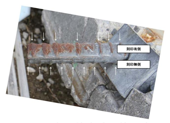
図 8.1.22 110R の B2 セグメントの中央のボルトボックス (ボルト及びボルトインサートが引抜けているが,ボルトインサートは 111R の K セグメントのものである。)
