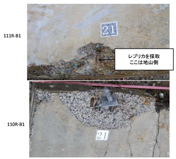
図 8.1.27 レプリカの採取箇所(111R の B1 セグメントのボルトインサート部)(110R の B1 のボルトボックスに、111R の B1 セグメントのボルトインサートが引抜けた形で残存していた)
