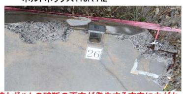
ボルトインサート部のコーン破壊とボルトの破断の両方が発生する方向に力がかかったと考えられる。
