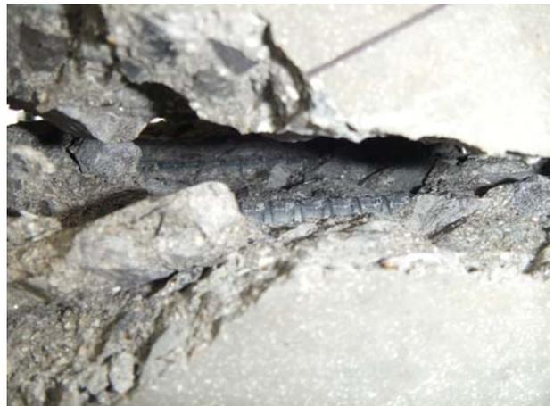
(d) 鉄筋とコンクリートの境界面で剥離
