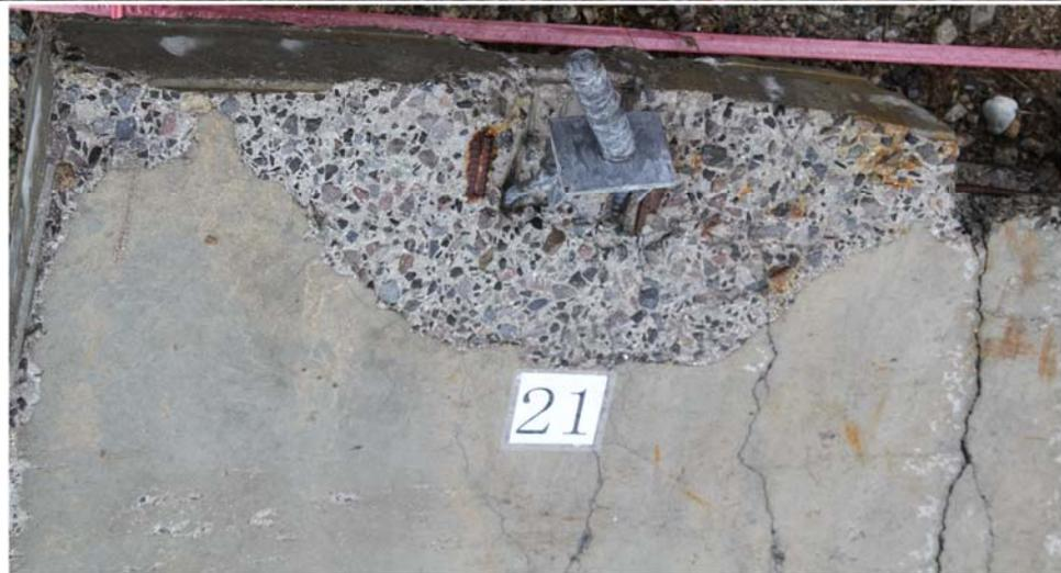
図 8.1.27 レプリカの採取箇所（111R の B1 セグメントのボルトインサート部）
