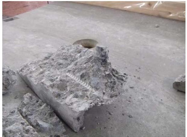
(f) ボルトインサート部を撤去後
