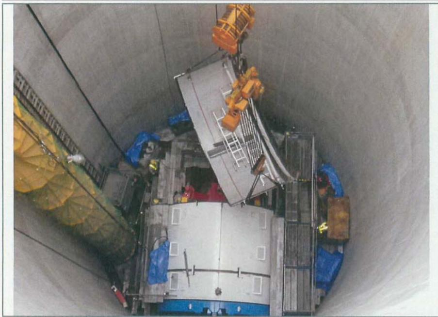
図 4.3.3 発進立坑内でのシールドマシン組立状況
