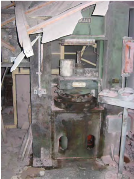
下方が焼損したプレス機
