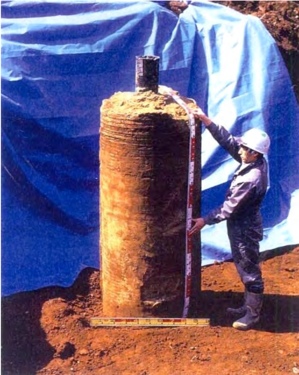
写真 3 羽根付き鋼杭の周りに付着して一体化したソイルセメントの様子
