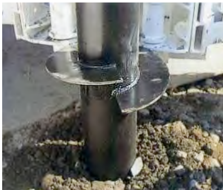
写真2 削孔あるいは原地盤に打設される鋼杭の様子、らせん状の羽根によって貫入能力を備える
