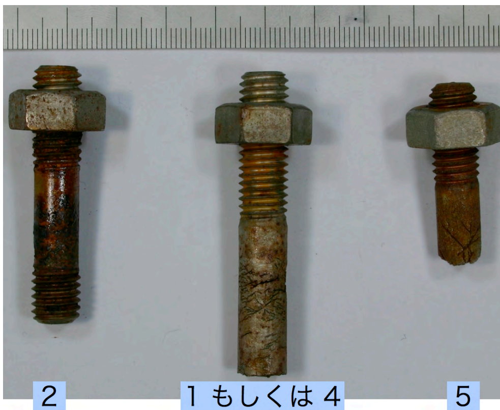
図3. 2 破断したボルトの外観
