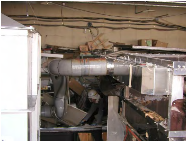
写真 6-14 生ごみ処理装置排気ダクト（呼び径 200）
