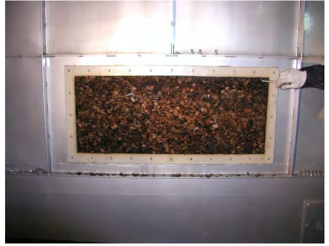
写真 6-49 微生物脱臭槽の側板を外したところ（木材チップ層が見える）
