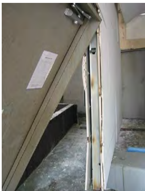
写真 6-23 生ごみ庫と生ごみ処理室を隔てる壁の破損状況（壁が生ごみ庫側に移動している）
