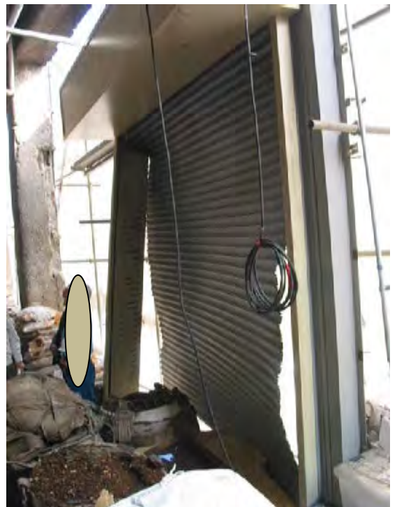
写真 6-6 生ごみ処理室側（室内側）から見たシャッターの破損状況
