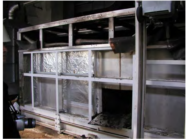
写真 6-13 生ごみ処理装置（発酵槽）の左側の様子 （側壁の一部が切断されている）
