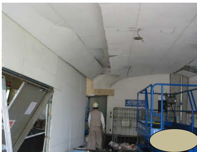
写真 6-22 生ごみ庫（分別台がある部屋で、左隣が生ごみ処理室）
