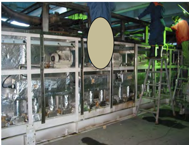
写真 6-30 エアレーションヒータとブロアの様子
