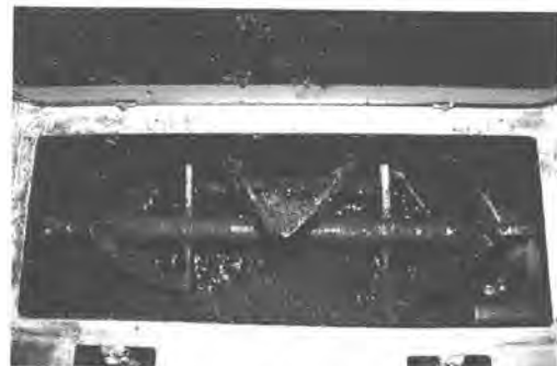
写真2 処理槽内部の焼損状況
