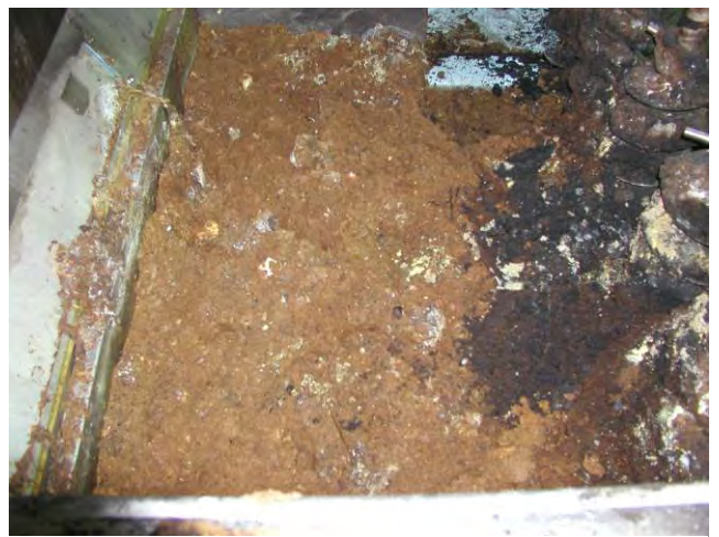
写真 6-40 生ごみ処理装置（発酵槽）内の堆積物を上から見たところ（右にオーガがあり、左が排出側）
