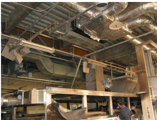
写真 6-16 生ごみ処理装置（発酵槽）上方，天井の 様子
