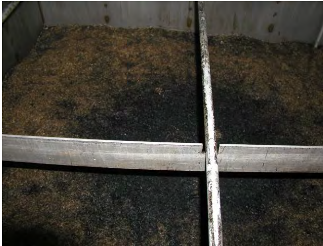
写真 6-48 微生物脱臭槽内部を斜め上から見たところ（中央付近が円形に炭化している）
