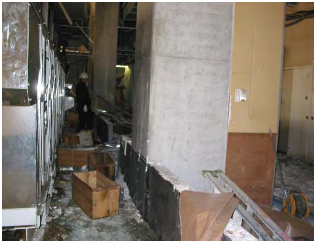
写真 6-20 生ごみ処理装置（エアレーションヒータ、ブロー側）と接する隣の部屋の壁の破損状況（壁が破壊して無くなっている）
