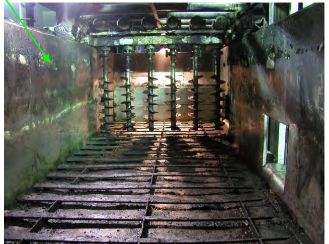
写真 6-35 生ごみ処理装置（発酵槽）内の堆積物をすべて取り出した後の様子（熱風吹き出しノズルとオーガ全体が見える）
