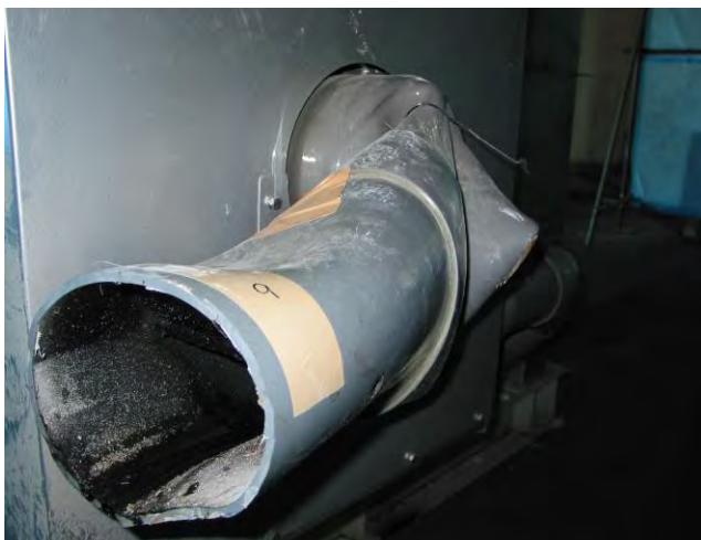
写真 6-46 排出ダクト（呼び径 200）の変形状況（微生物脱臭槽に接続）
