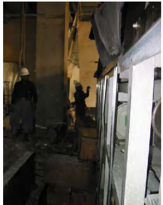
写真 6-21 写真 6-20 を反対方向から見たところ（隣の部屋（左側）で壁が破壊して無くなっている）
