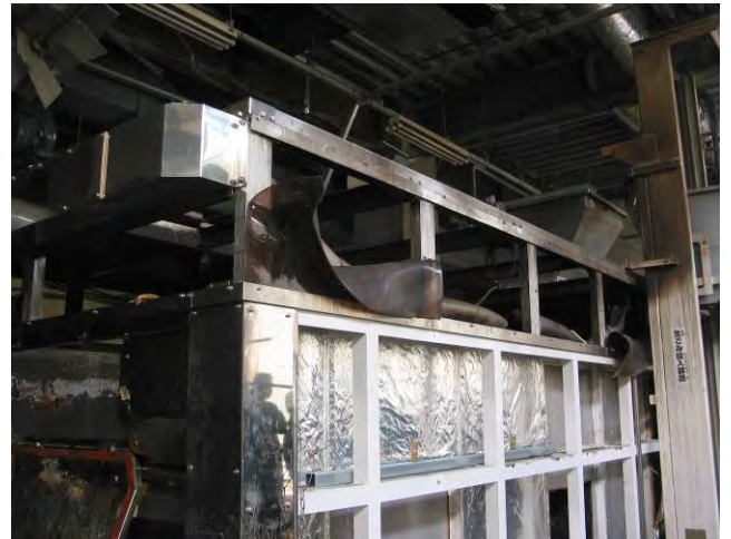
写真 6-15 生ごみ処理装置（発酵槽）を斜め左から 見たところ
