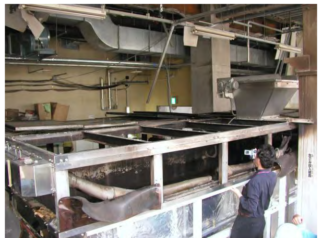
写真 6-17 生ごみ処理装置（発酵槽）上部の様子
