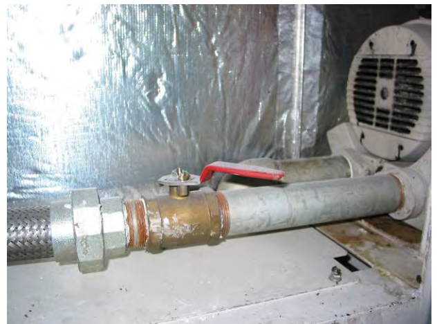
写真 6-31 ブロア吐出側に取り付けられていたボールバルブ
