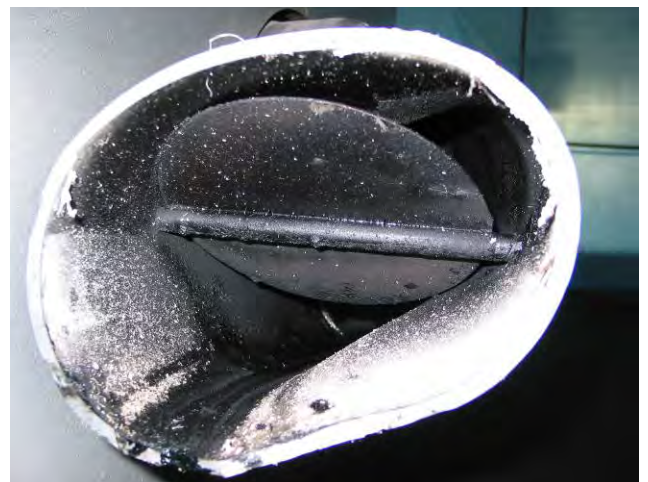
写真 6-47 排出ダクト（呼び径 200）内に取り付けであった流量調整ダンパを上流側から見たところ）
