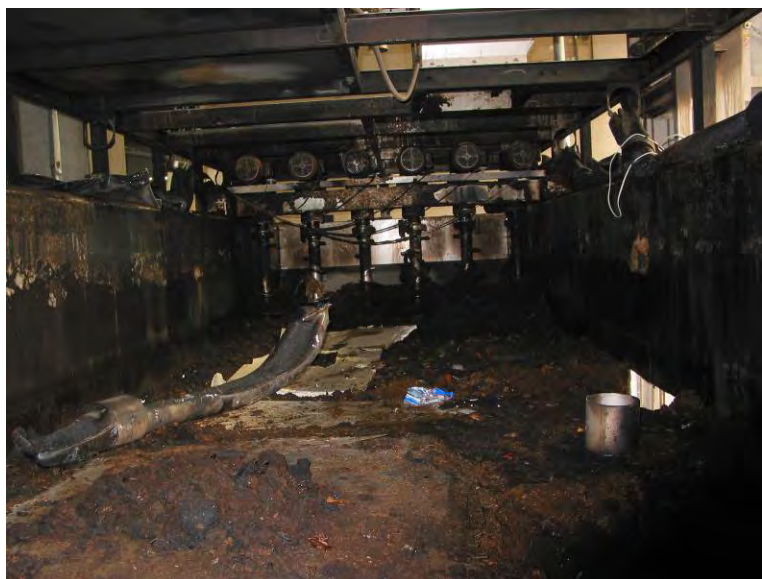
写真 6-25 生ごみ処理装置（発酵槽）内を掃除口左から見たところ
