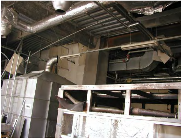
写真 6-12 生ごみ処理装置（発酵槽）の左側の様子 （奥が微生物脱臭装置）
