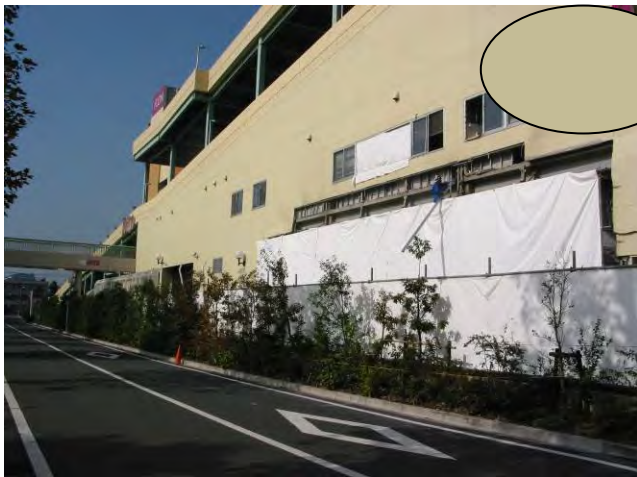
写真 6-3 生ごみ処理室を道路側から北西方向に見たところ
