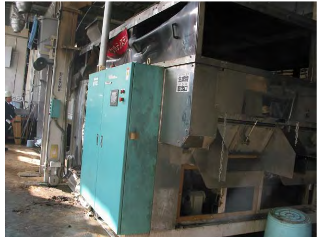
写真 6-8 生ごみ処理装置を右から見たところ（エメラルドグリーン色のボックスが制御盤）
