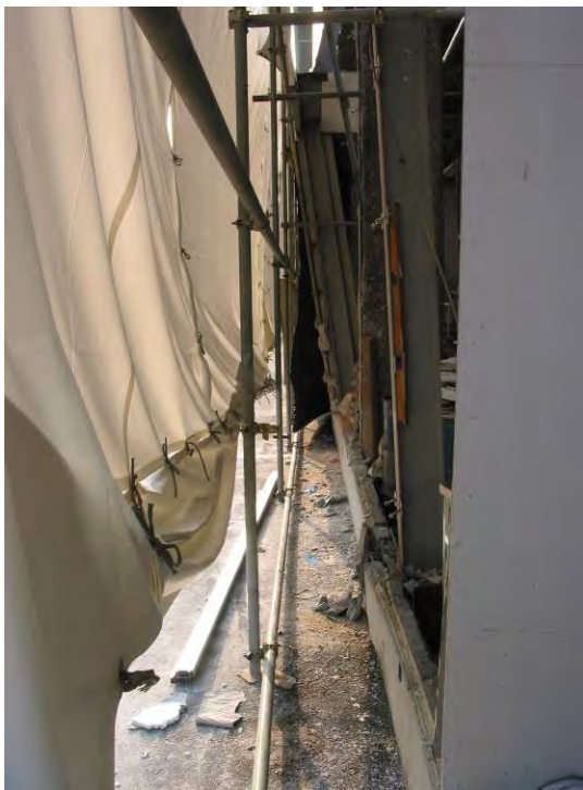
写真 6-5 生ごみ処理室の外壁の破損状況
