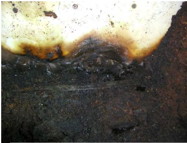
写真 6-37 プラスチック内壁板の焼損状況
