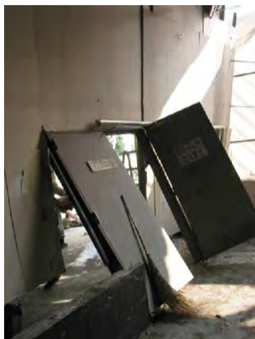
写真 6-24 生ごみ処理室から生ごみ庫の方向を見たところ
