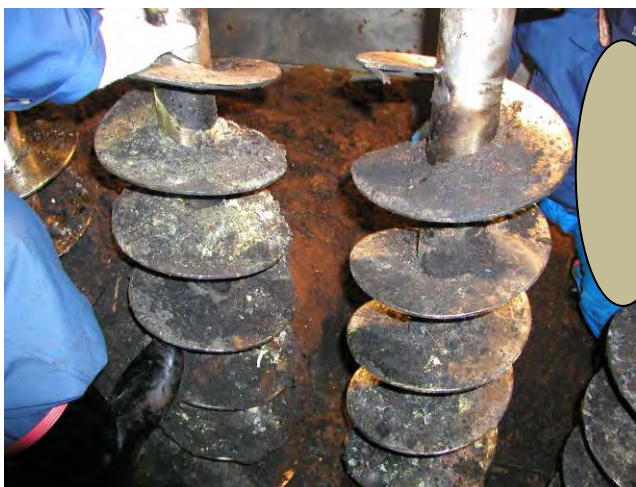
写真 6-41 オーガ付近をかき出した状況（排出側方向を見たところ）
