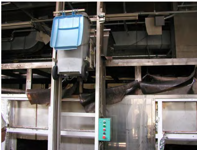
写真 6-9 ホッパーローダー（生ごみ投入容器が途中で止まっている）
