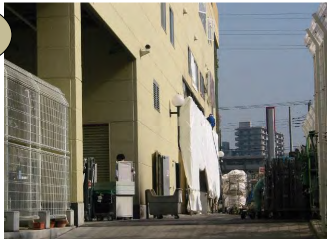
写真 6-4 生ごみ処理室を外壁に沿って東方向に見たところ
