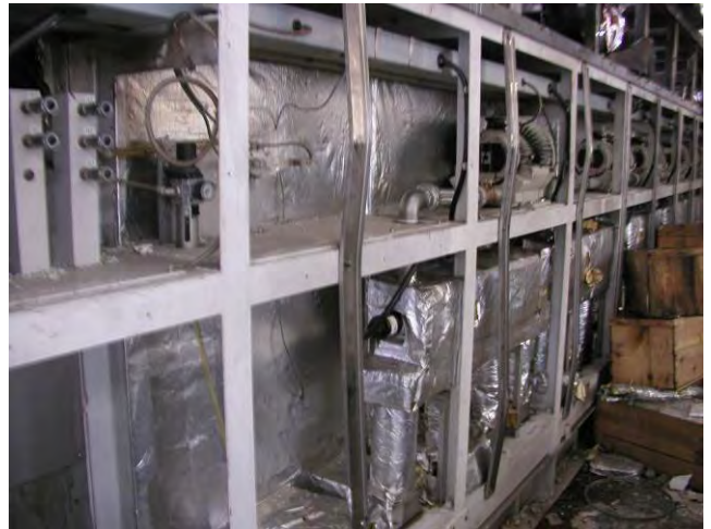
写真 6-19 生ごみ処理装置（発酵槽）をエアレーションヒータ、ブロー側から南西方向に見たところ
