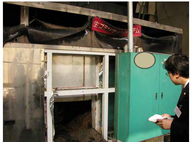
写真 6-10 制御盤を斜め左から見たところ(内部を調べるため2箇所、側壁の一部が切断されている)
