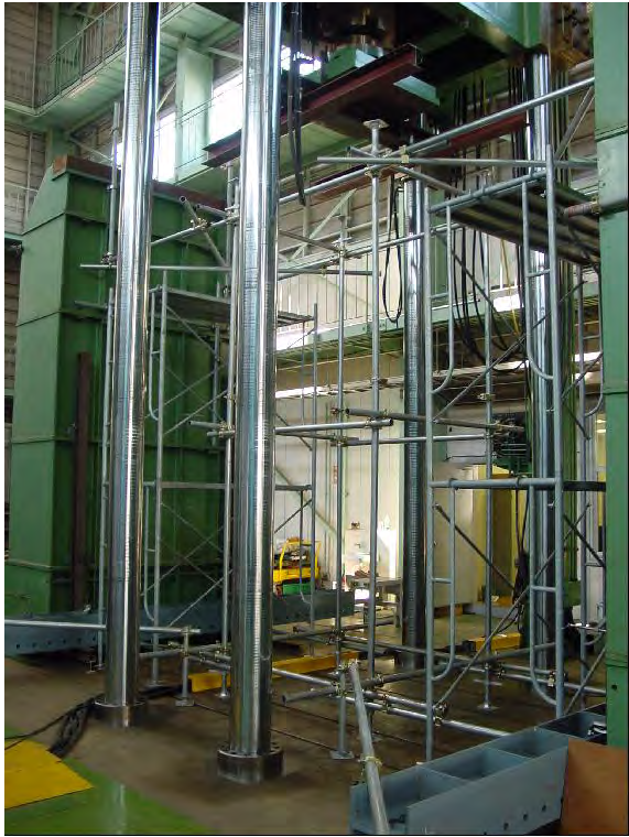
写真1-1 ケース1 (2層足場)
