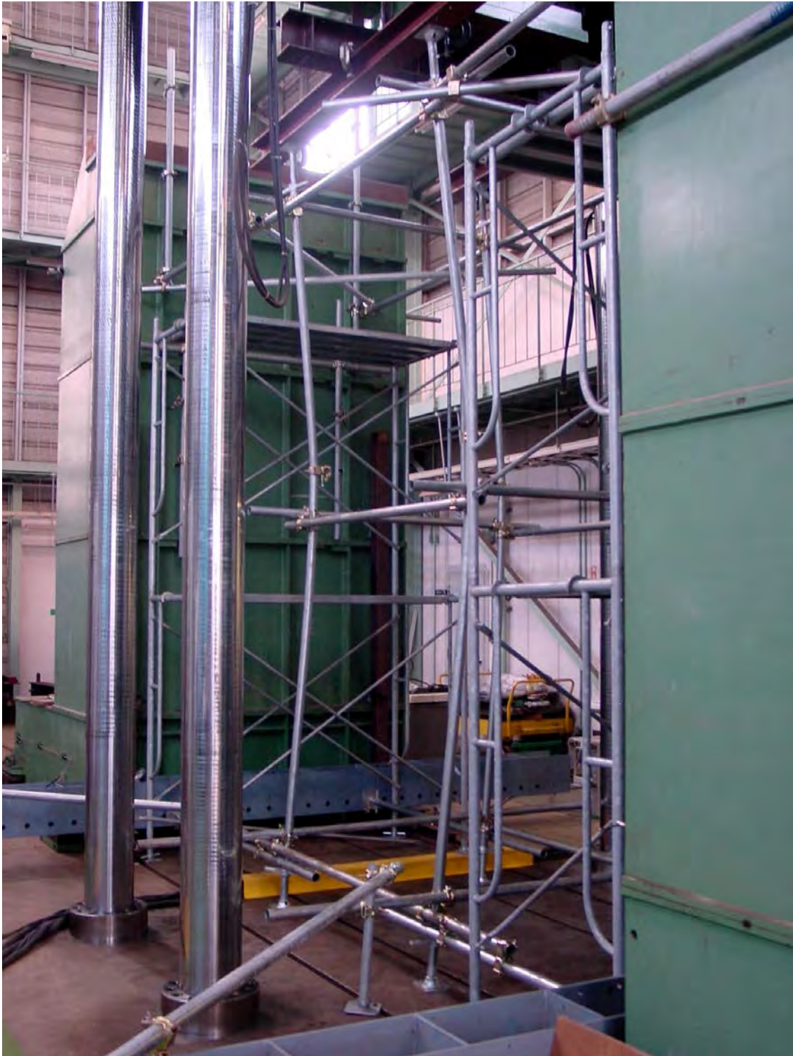
写真1-4 ケース1（2層足場）の座屈形
