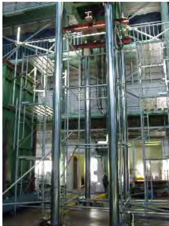
写真1-3 ケース3 (3層足場、控えあり)
