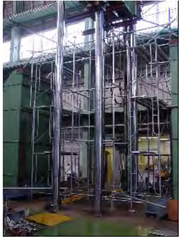
写真1-2 ケース2 (3層足場、控えなし)
