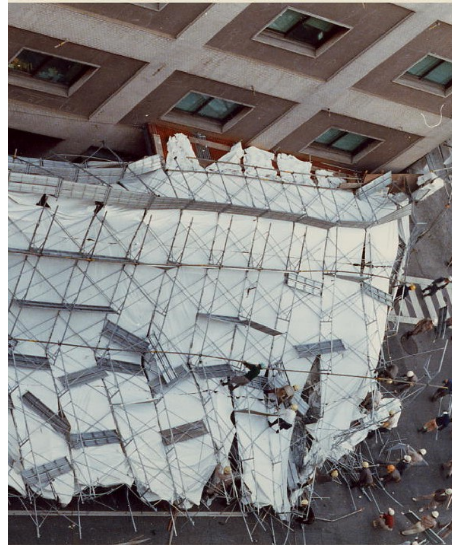
建設現場における足場
