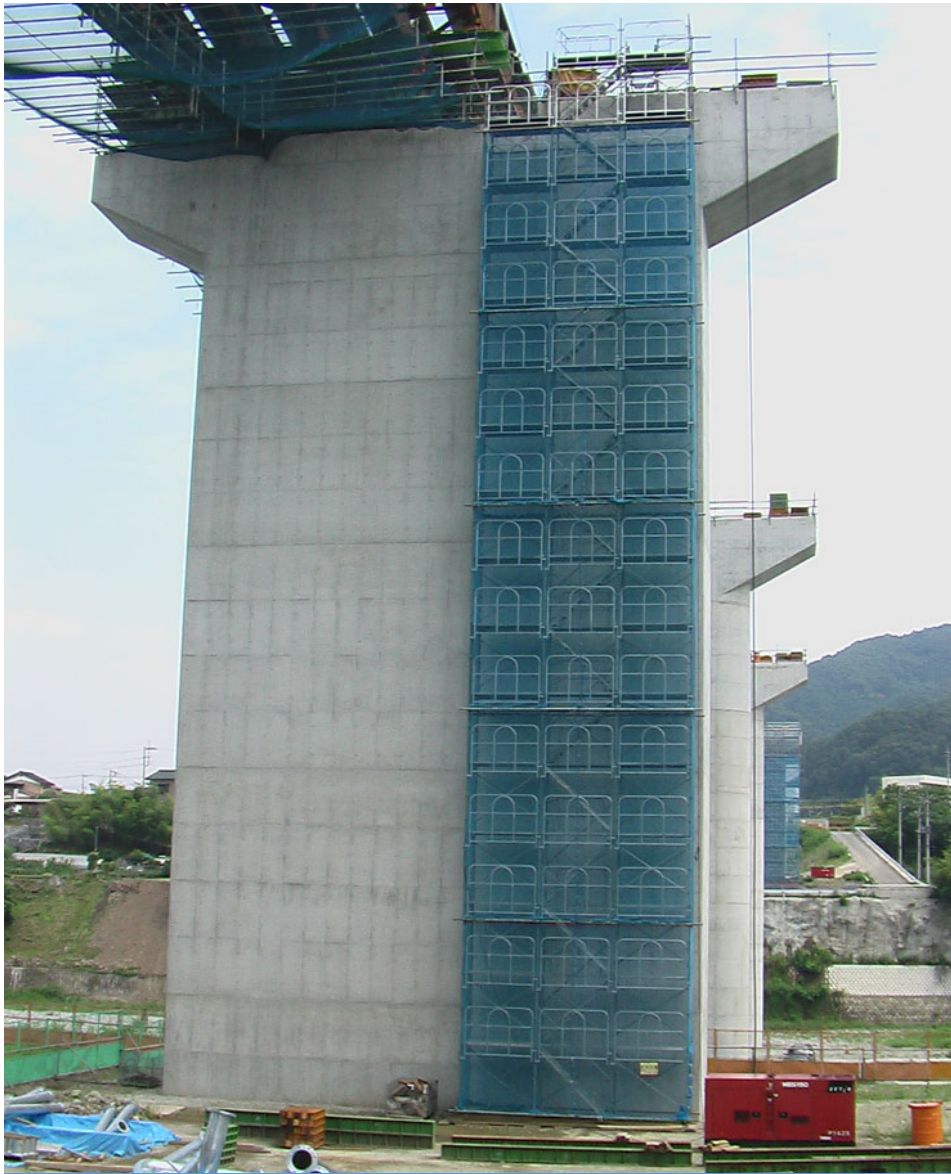
手すり先行足場を用いた足場
