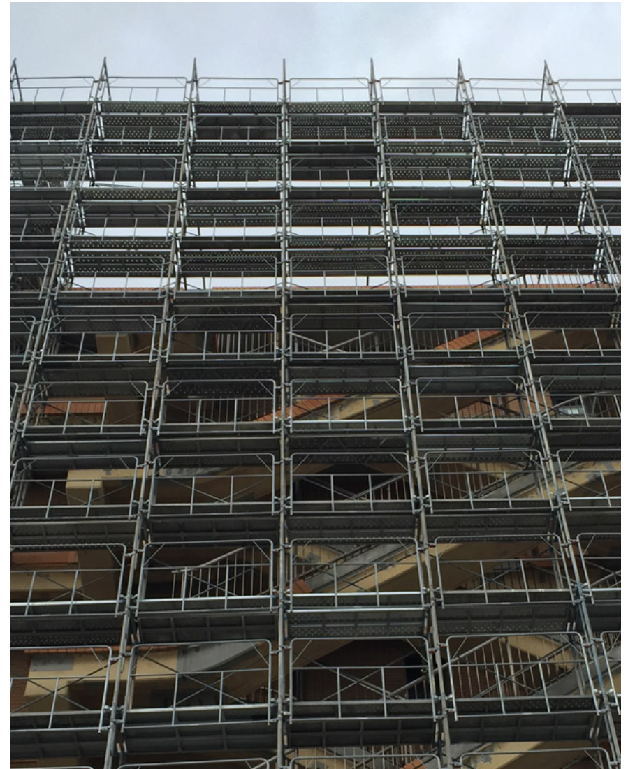
建設現場における足場
