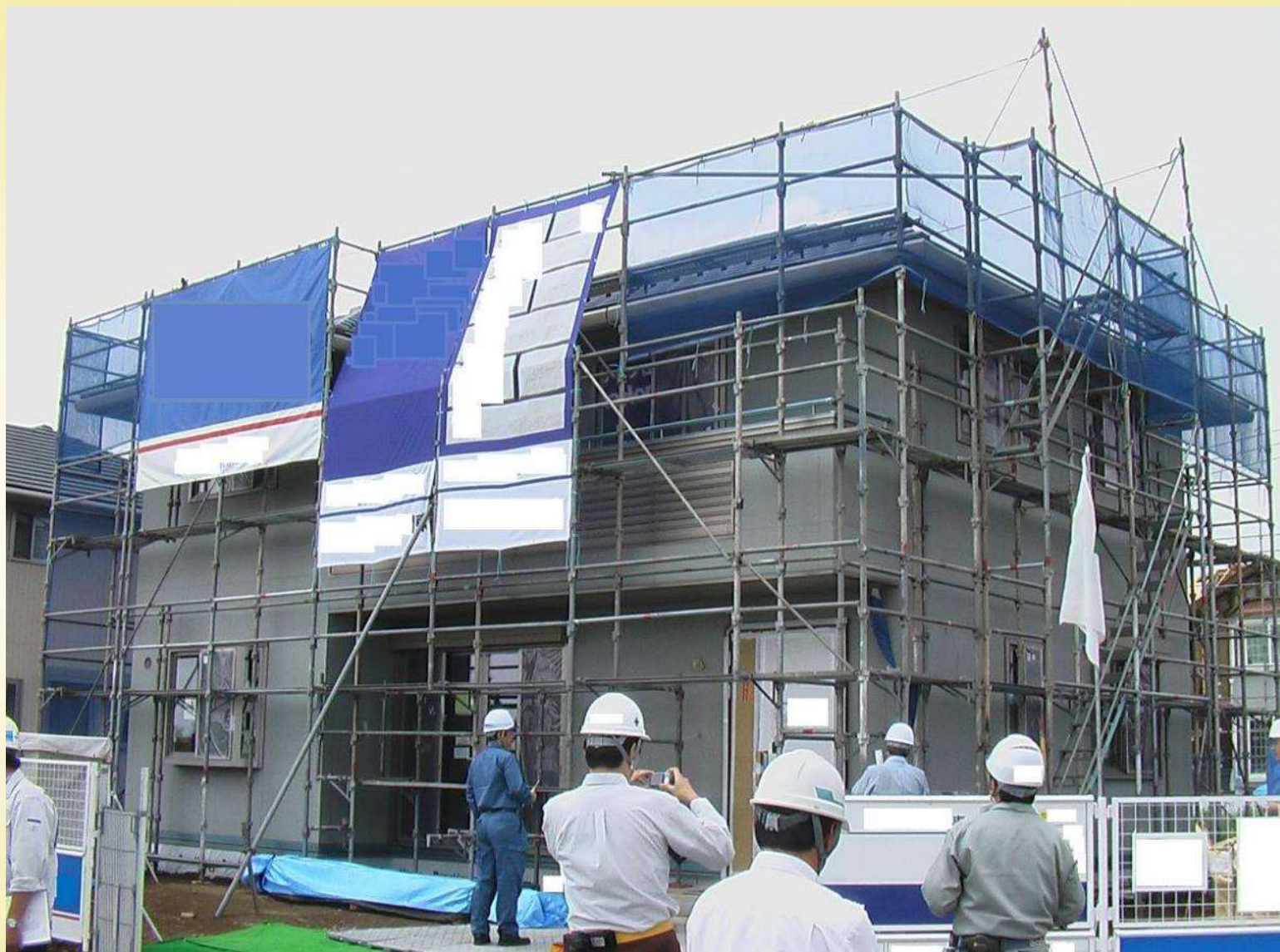
足場先行工法により建築された住宅
