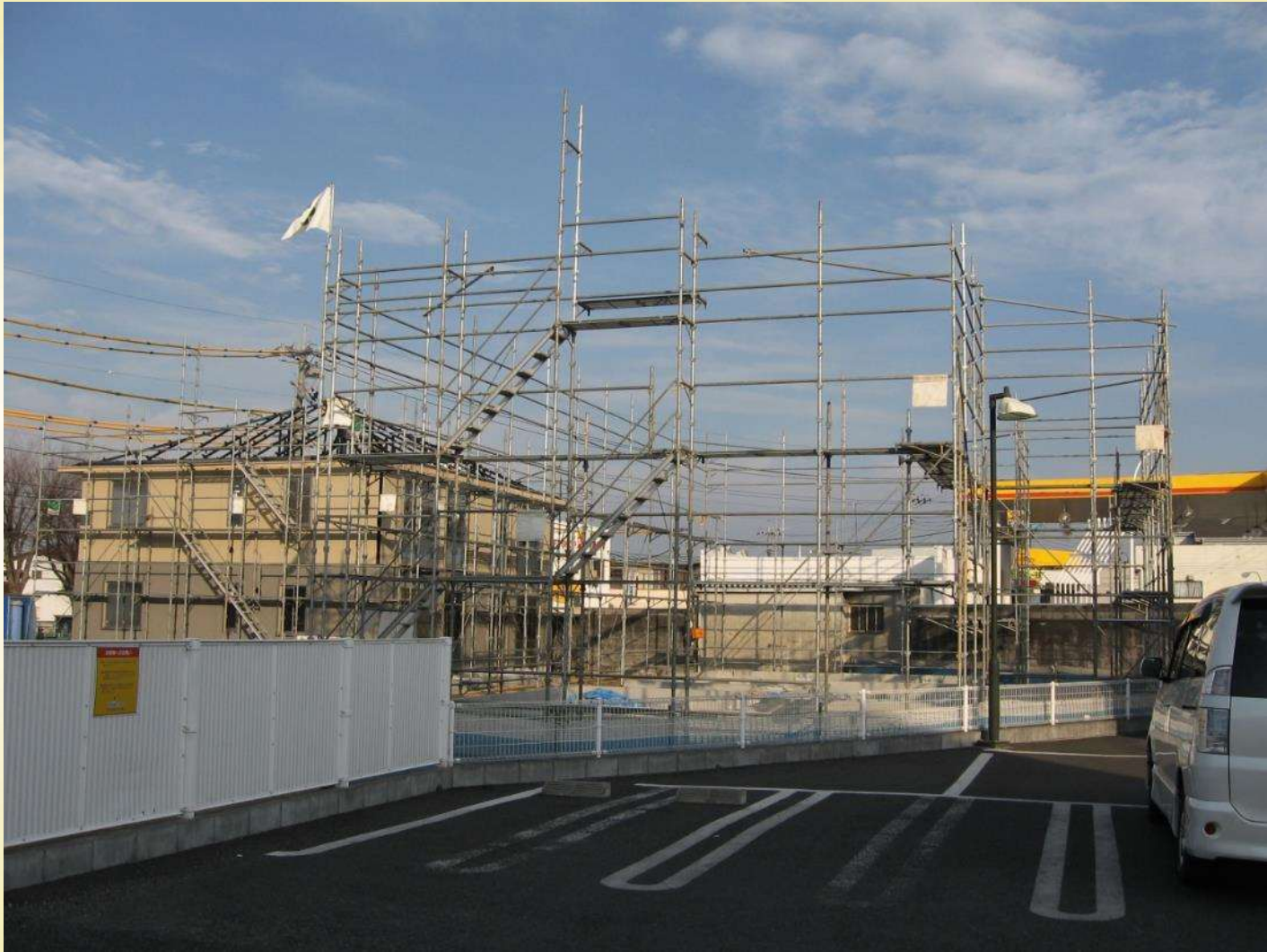
足場先行工法(住宅の柱や梁を建てる前に足場を設置)
