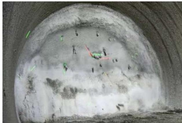
図-3.4 鏡クラック自動検知システム<sup>6)</sup>
