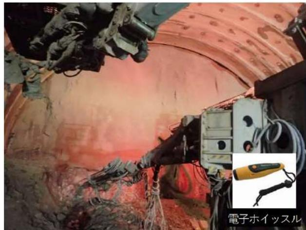
図-3.3 警報装置<sup>6)</sup>
