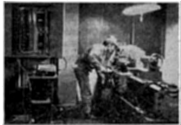
図 16 シャ断器の現地モニタ (負荷旋盤)
