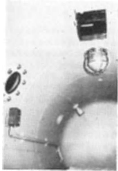
写真 12 グローブおよび2層金網付き60W 白熱灯、スピーカーマイク、呼出用無接点スイッチおよび隔測温度計センサー
