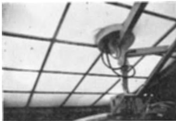
写真 28 外部照明方式(半透明プラスチック板による“光り天井”方式の採用)
