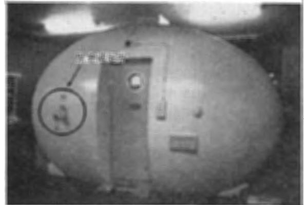
写真 83 タンク外から操作する緊急減圧弁
