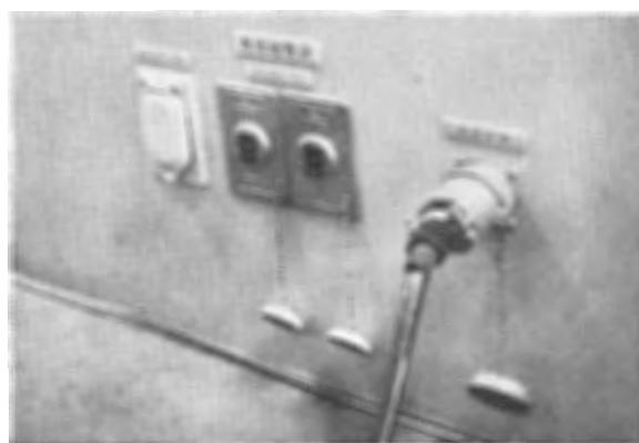
写真 51 非接地式電路からのコンセント (100 V, 10 A) および通話用コンセント (ケーブルが接続されているもの)
