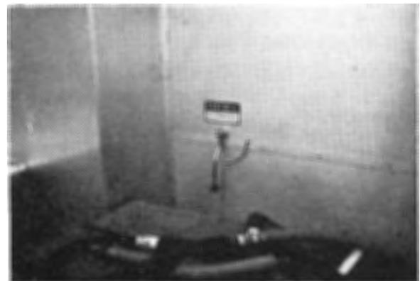
写真 84 タンク内で操作する緊急減圧弁
