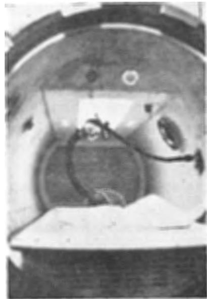
写真 13 半透明プラスチックカバー付き40W けい光灯、スピーカー、マイクおよびME用コンセント
