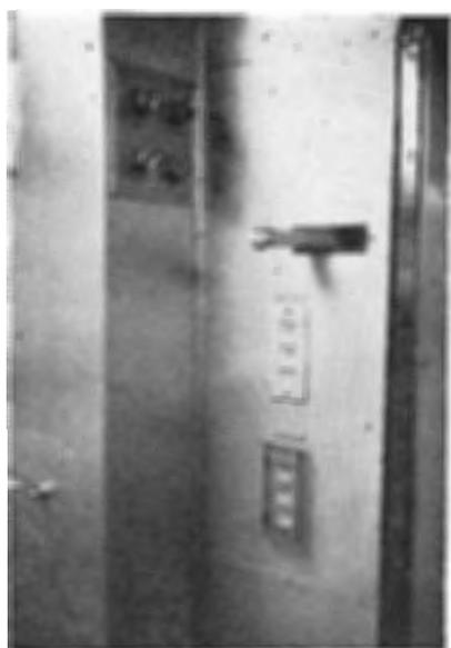
写真 49 ドア開閉用タッチスイッチ、パイロットランプ（手術室制御および異常警報用）およびブザー（ドア開閉警報用）
