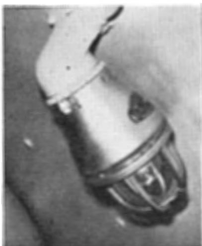
写真 32 内部照明方式 (120 V, 150 W の耐圧防爆構造—アメリカ製, Class I, Group B, C, D の白熱電灯)
