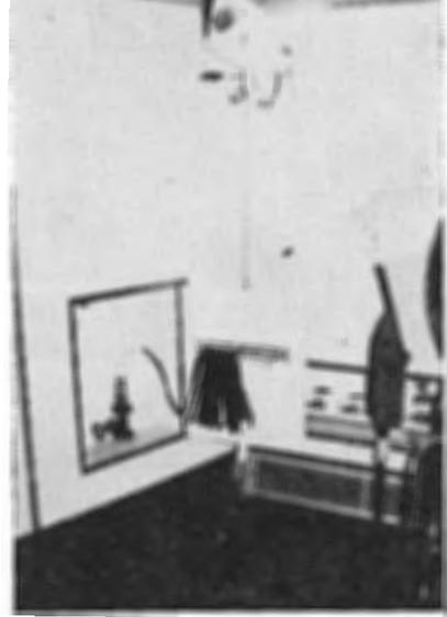
写真 46 全体監視用 I T V と消火栓 (屏を開くと電源が自動的にしゃ断される)
