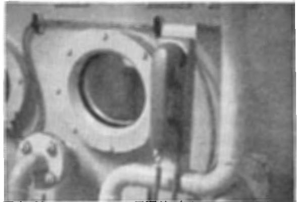
写真 62 インターホン用配線 (ビニルチューブをかぶせてある)
