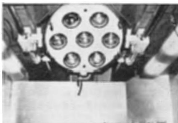
写真 34 10~4kg/cm<sup>2</sup> のゲージ圧力に耐える手術灯 (24 V, 40 W × 7 灯)
