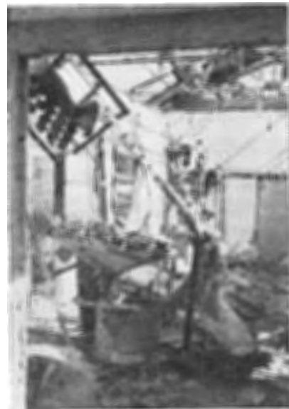
写真 2 アルミ篩別工場の爆発現場
