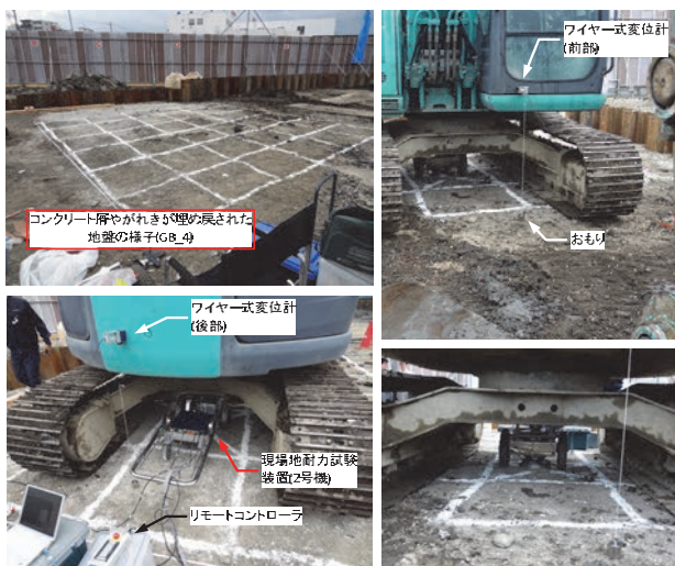
写真 4-12 GB_4 における現場地耐力試験の様子
