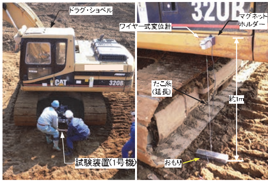
写真 4-10 試験装置のセットと変位計の配置
