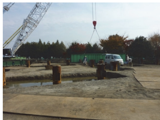
写真 4-13 工事現場 GB_5 の全景
