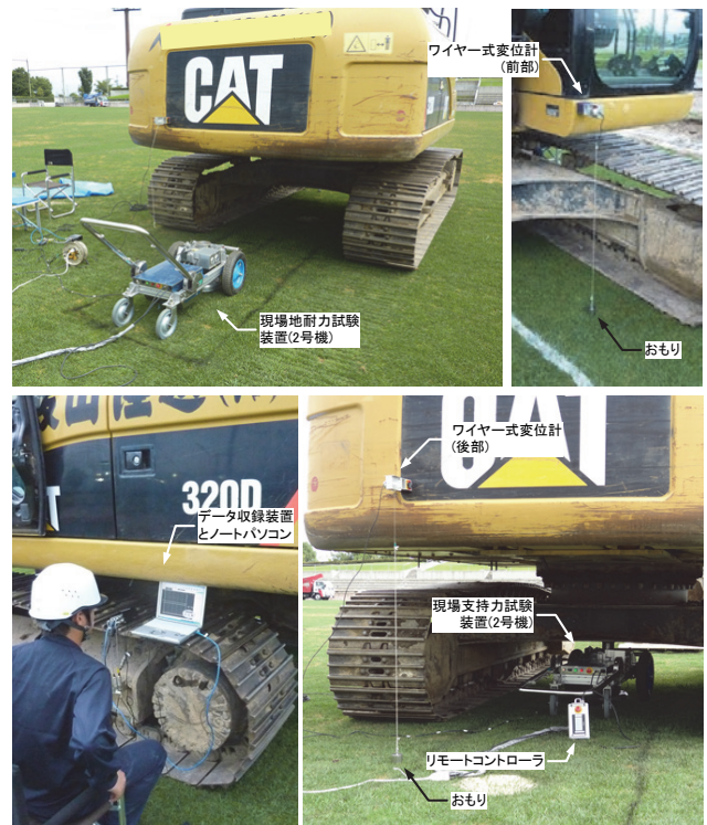
写真 4-17 GB_6 における現場地耐力試験の様子
