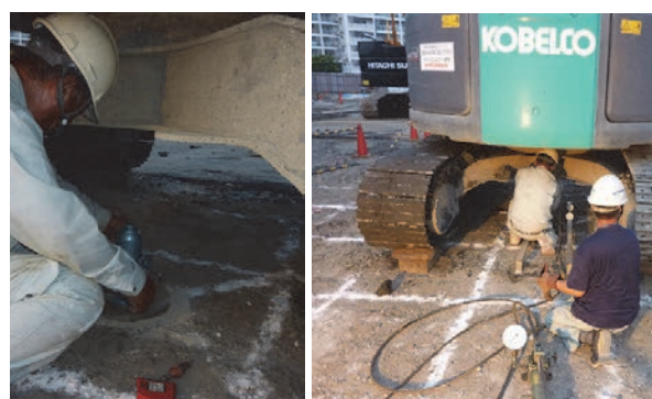
a) 荷重装置と計測装置の設置作業
