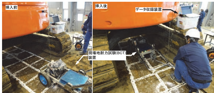
図 5-10 BCT 装置の設置
