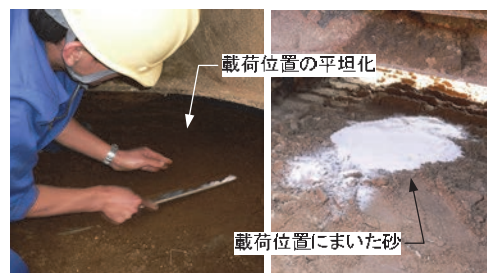
写真 4-9 載荷位置の地表面の養生
