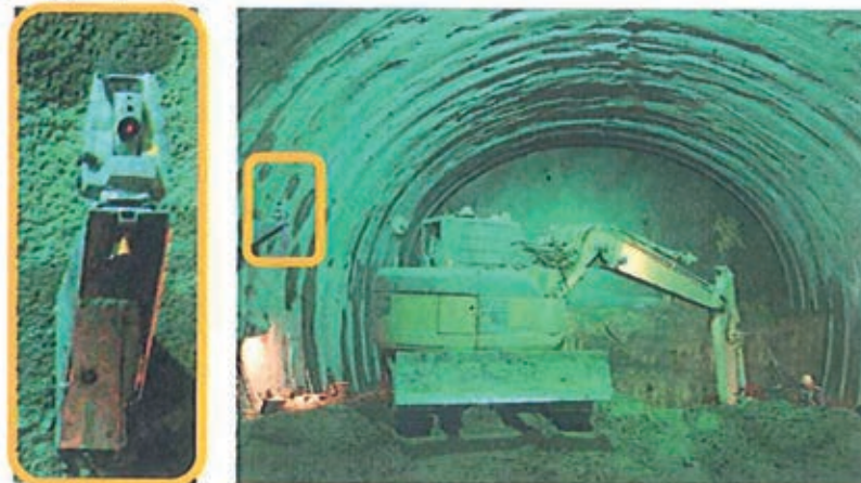
図-19 切羽変位計測の事例② 21)
