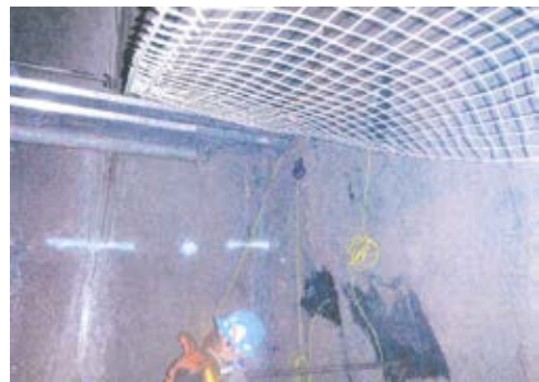
写真-3 ネットの使用状況
