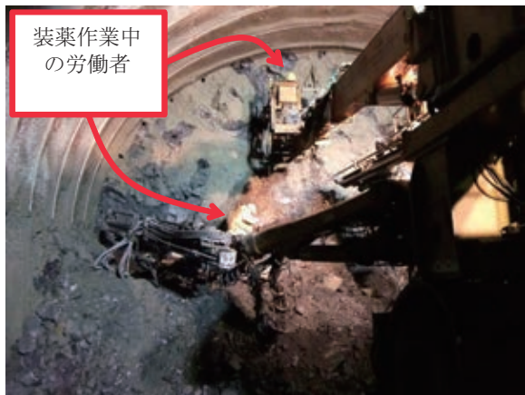
写真-1 ナトム工法における装薬作業
