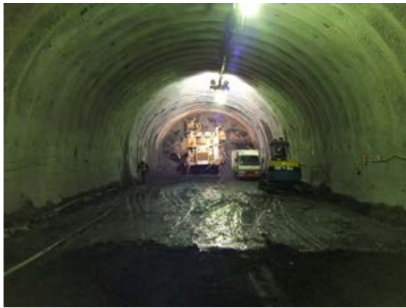
写真-2 トンネルの切羽の照度確保の例
