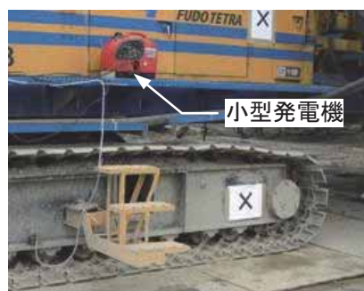
写真 4-5-5 車載した小型発電機
