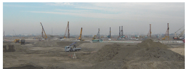
写真 4-1-2 多数のくい打機が稼働する整備地区現場の様子
