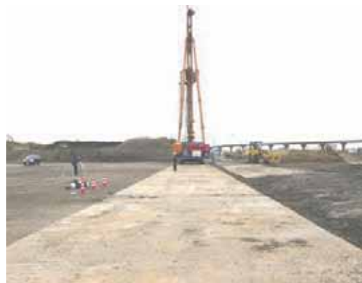
写真 4-5-2 敷鉄板が敷設された走行路の様子
