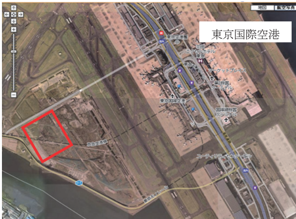
写真 4-1-1 東京国際空港を上空から見た様子と国際線地区エプロン等整備事業の実施箇所(枠部分)
