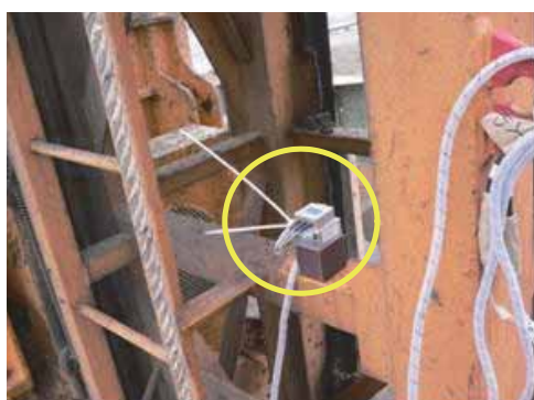
a) Acc1 の設置状況
