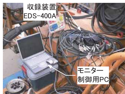
写真 4-5-4 上部旋回体に配置した計測装置
