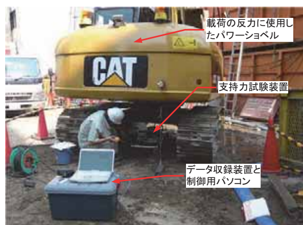
写真 4-4-3 機体変位量の測定
