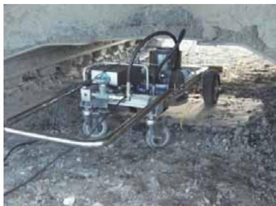
写真 4-4-1 下部走行体と支持地盤の間に設置した現場支持力試験装置
