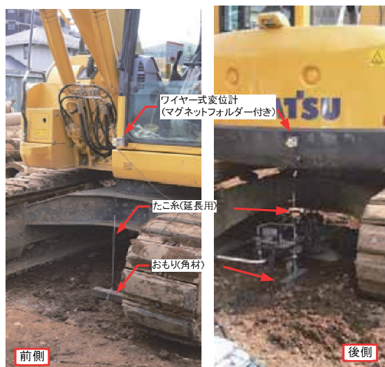
写真 4-4-2 機体の浮き上がり変位量の測定 (左：前部の様子, 右：後部の様子)
