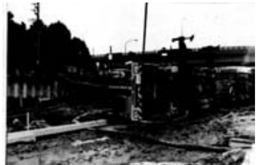
2) トラッククレーンの転倒
