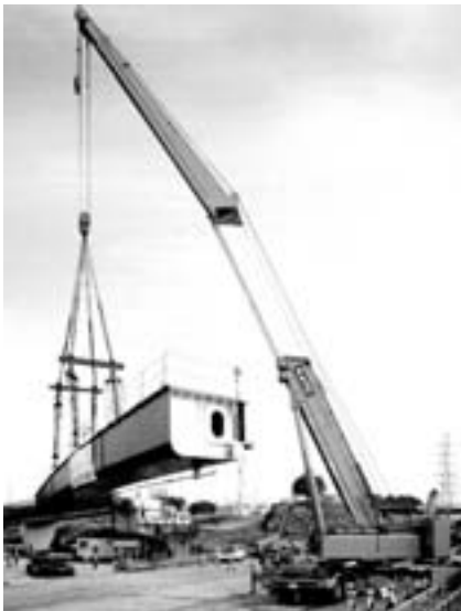
図1-4 トラッククレーン (ボックス式)
