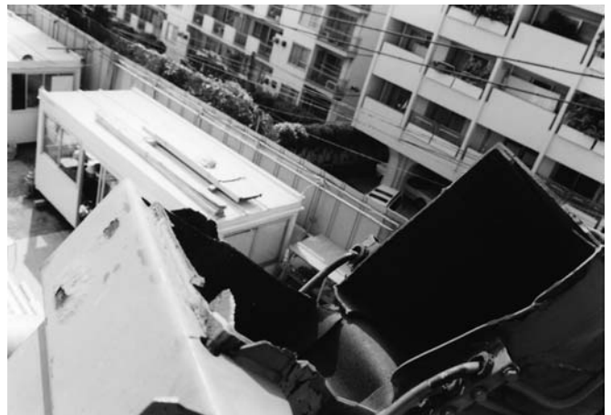
Photo 2 Broken section of the boom. ブーム折損部の様子
