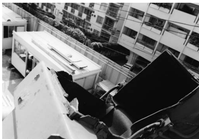
Photo 2 Broken section of the boom. ブーム折損部の様子
