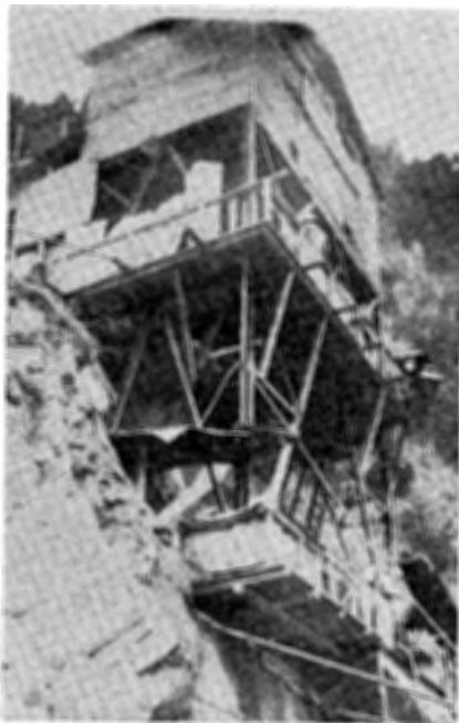
第 1 図 倒壊したものと同型のバッチャープラント
