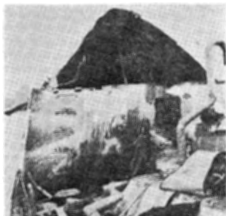
写真 4 船員室の破壊状態
