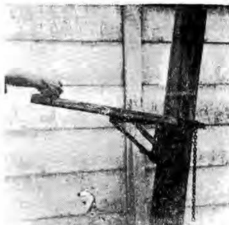
図 1 作 業 用 仮 足 場
