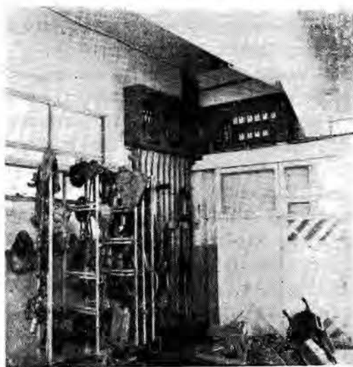
図5 分電盤の取付位置が高いと操作や回路の点検保守を行う場合に困難である。
