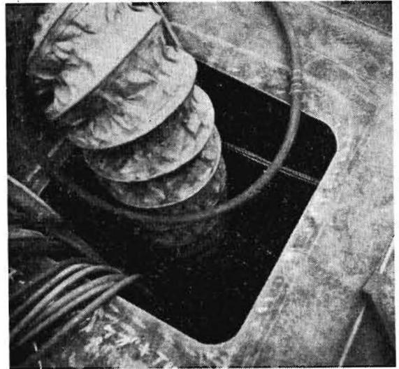
図14 マンホールに管を入れて換気している
