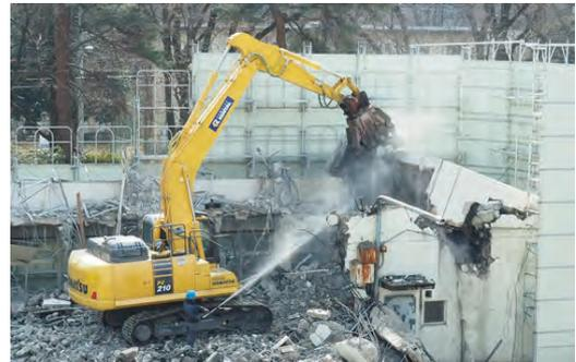
図1 解体用機械を用いた転倒工法
