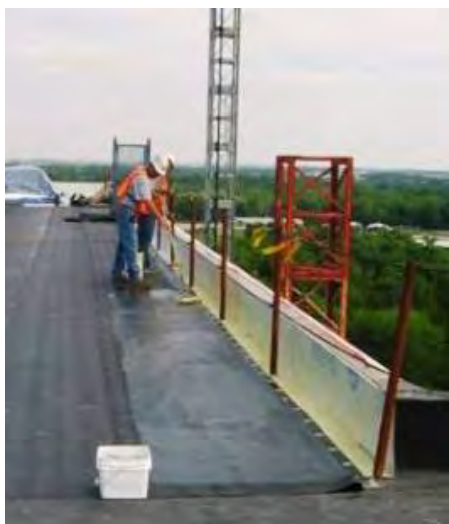
図4 墜落危険個所に設置された手すり 2)
