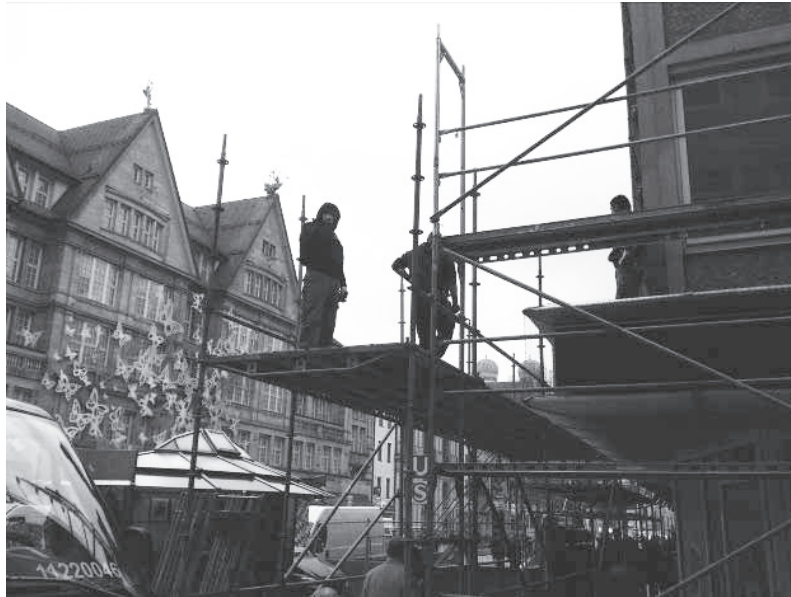
図8 足場の組立・解体時に安全帯を使用せずに作業を行っている状況(2013年撮影)
