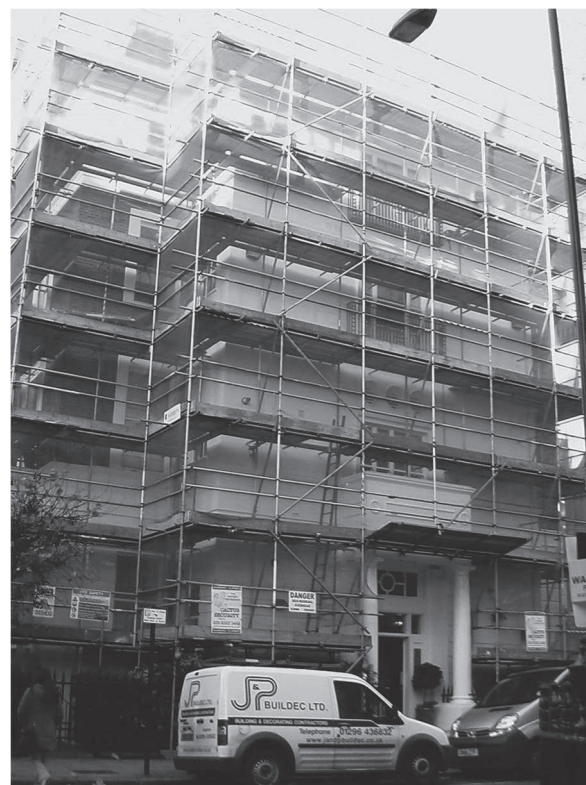
図 1 ロンドンにおける足場 (手すりに加え、中棧、幅木が設置してある)
