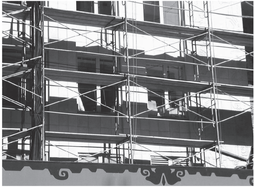
図3 サンフランシスコにおける足場 (交さ筋かいの下に下棧が設置してある)
