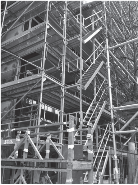
図2 ミュンヘンにおける足場 (中棧が、階段、妻側にも設置してある)
