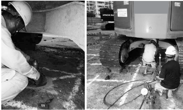
a) 載荷装置と計測装置の設置作業
