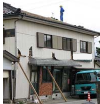
写真1 損傷を受けた建物の解体工事の様子
