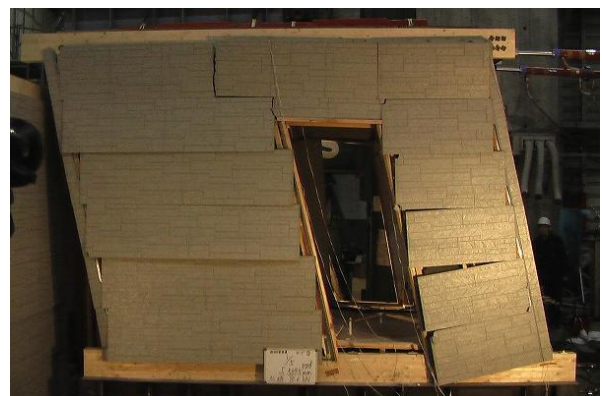
写真5 サイディング試験体の既変形状況 (R=1/8)
