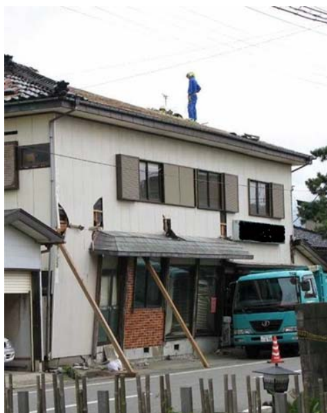
写真1 建築物の補強例
