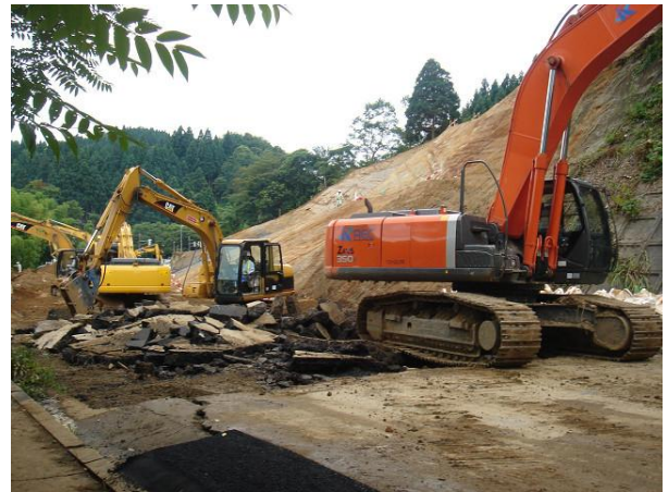
写真 1 新潟県中越沖地震にて被災した国道 8 号大積の応急復旧工事
