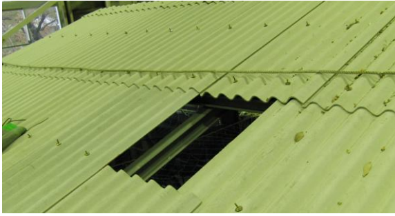
写真5 波板スレート屋根の実験時の状況
