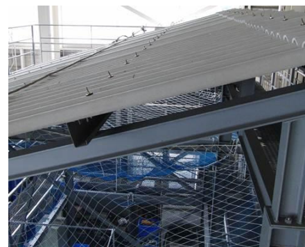
写真1 屋根裏へ安全ネットを設置する対策
