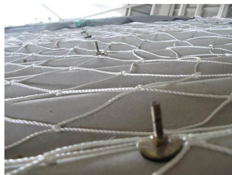
写真2 屋根上に安全ネットを設置する対策
