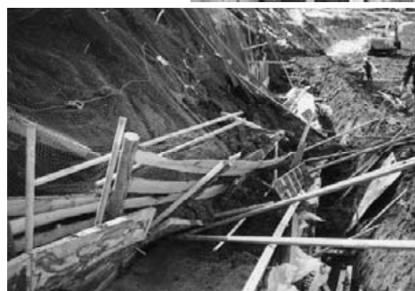
図1 簡易な土止めが機能せず崩壊した災害事例
