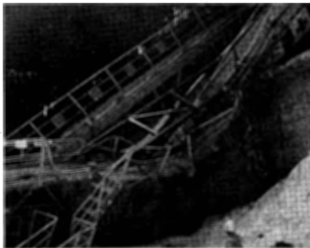
Fig.9 Collapsed overhead travelling crane. 天井クレーンの損壊状況
