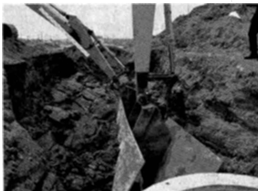
Photo 2.4 A fatal accident due to Type-3 (a) failure. タイプ3による崩壊
