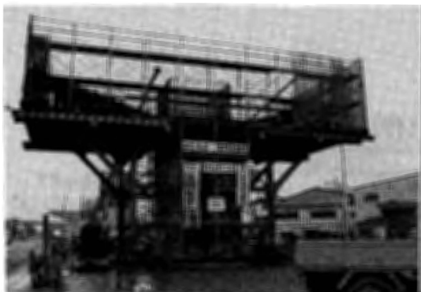
Photo 1 Steel H type shoring H 形鋼支柱式型枠支保工
