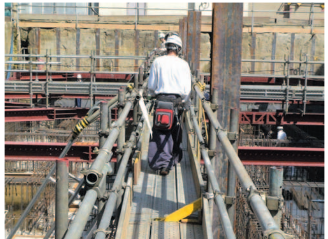
猛暑の炎天下でも安全のため夏服軽装は許されない建築工事現場の作業風景
