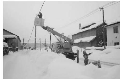
厳冬期における屋外での電気通信工事作業
