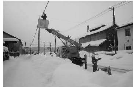
厳冬期における屋外での電気通信工事業業
