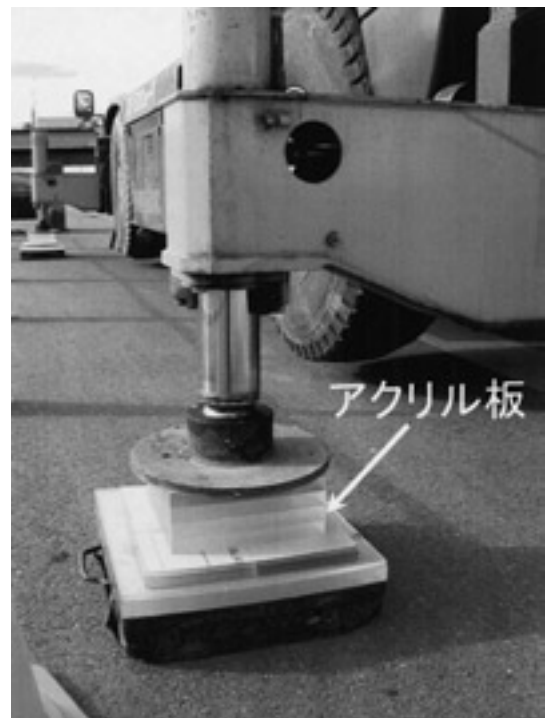
Fig. 14 Setting of a rough-terrain crane with an acrylic plate inserted under the outrigger float. アウトリガーフロートの下にアクリル板が挿入された状況
