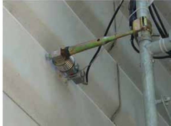
写真1 足場、建物、壁つなぎの取り付け部分
