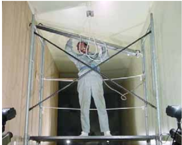
写真1 床付き布枠の取り付け・取り外し作業
