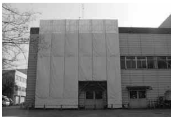
写真1 7層6スパンの実測用わく組足場
